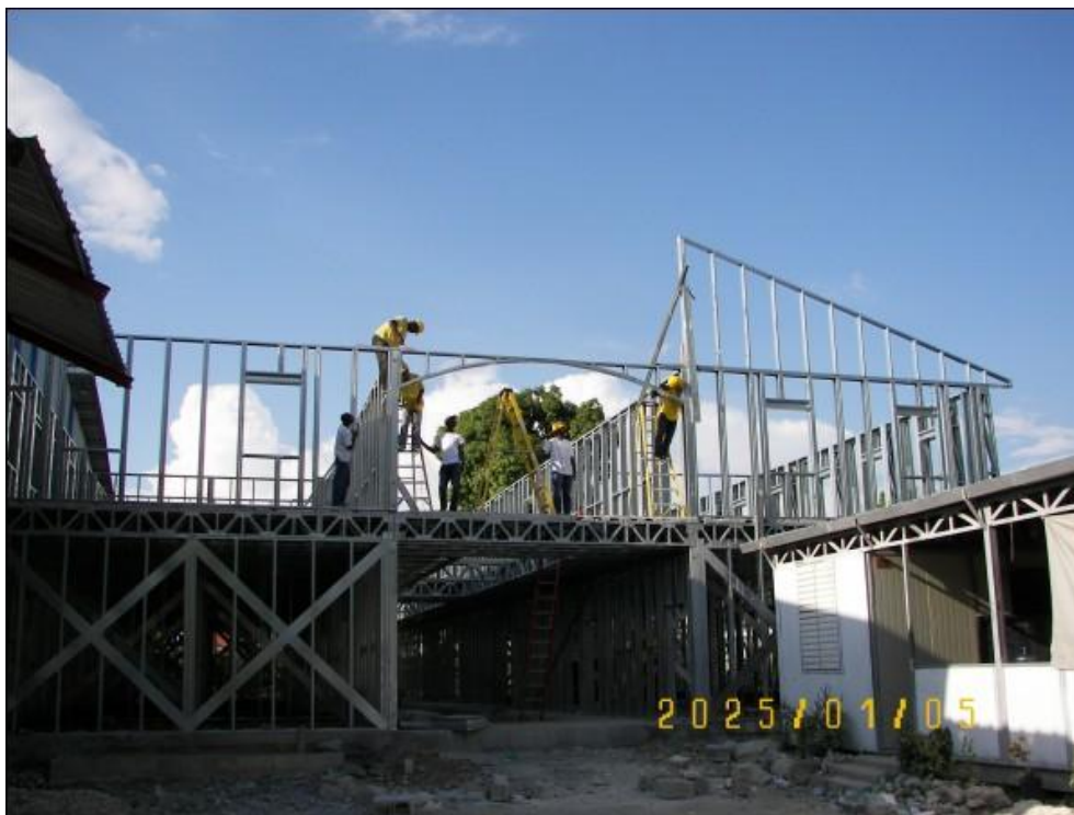
Le montage des structures métalliques
